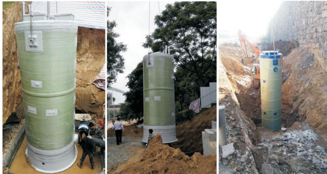
应确保使用适当的起重或吊运设备从卡车上卸载泵站，吊具，吊索，卸扣的规格满足设备自重要求。井筒长度超过10m，需要用两台载重适当的起吊设备作业。使用适当的吊索通过卸扣和吊耳起吊泵站。小心地卸载并安全放置在地面上，尽量使泵站底部整体同时着地，尽量避免底部圆弧局部承重。
