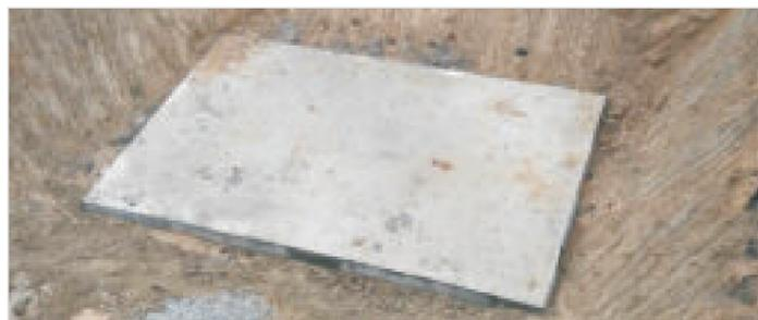
注：混凝土底板可预制，也可以在基坑内直接浇筑。
