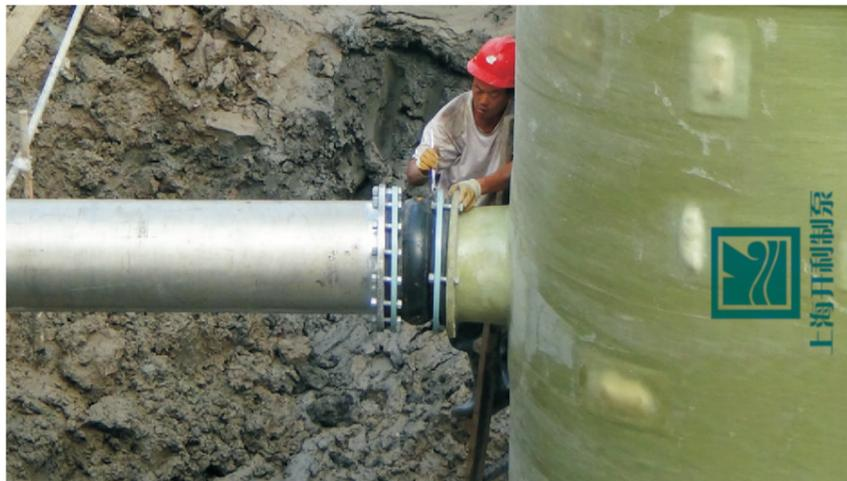
连接前，要在泵站井筒四周用鹅卵石或者沙子回填到连接管的最低面，并压实。进口端安装应检查：管和密封圈必须干净，进水管对准连接处，连接的地脚螺丝要固紧。法兰节要确保密封严实，对准管（无压力），对称均匀紧固。
